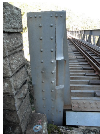
Remplacement de la semelle d'un montant déchiré
