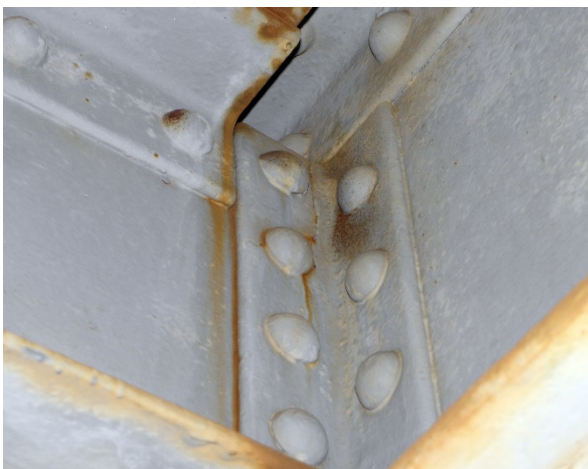
Remplacement d'une cornière fissurée
