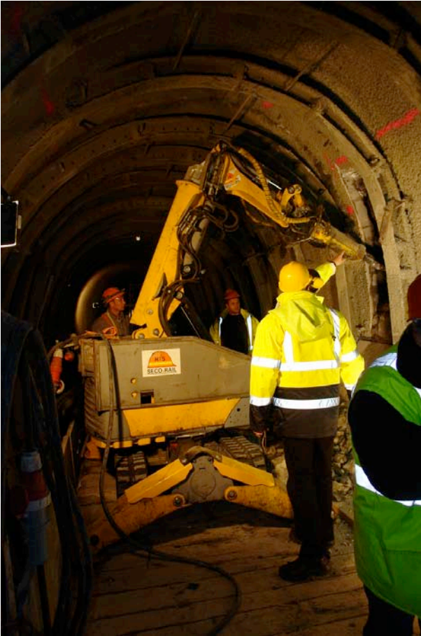
Tunnel de Ponte Rotto - Réalisation de nervures à l'intérieur du parement en maçonnerie
