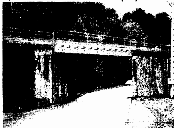
RN 193 - Pont de Venaco - Pont projet
