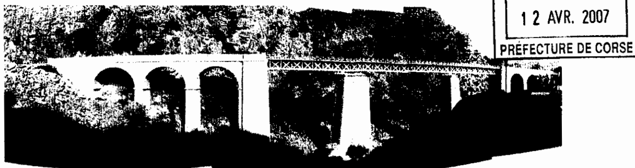
Fig. 1 - Pont sur le Golo
