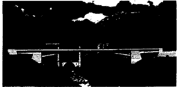
Pont du Vecchio 42,5 m-137,0 m-42,5 m
